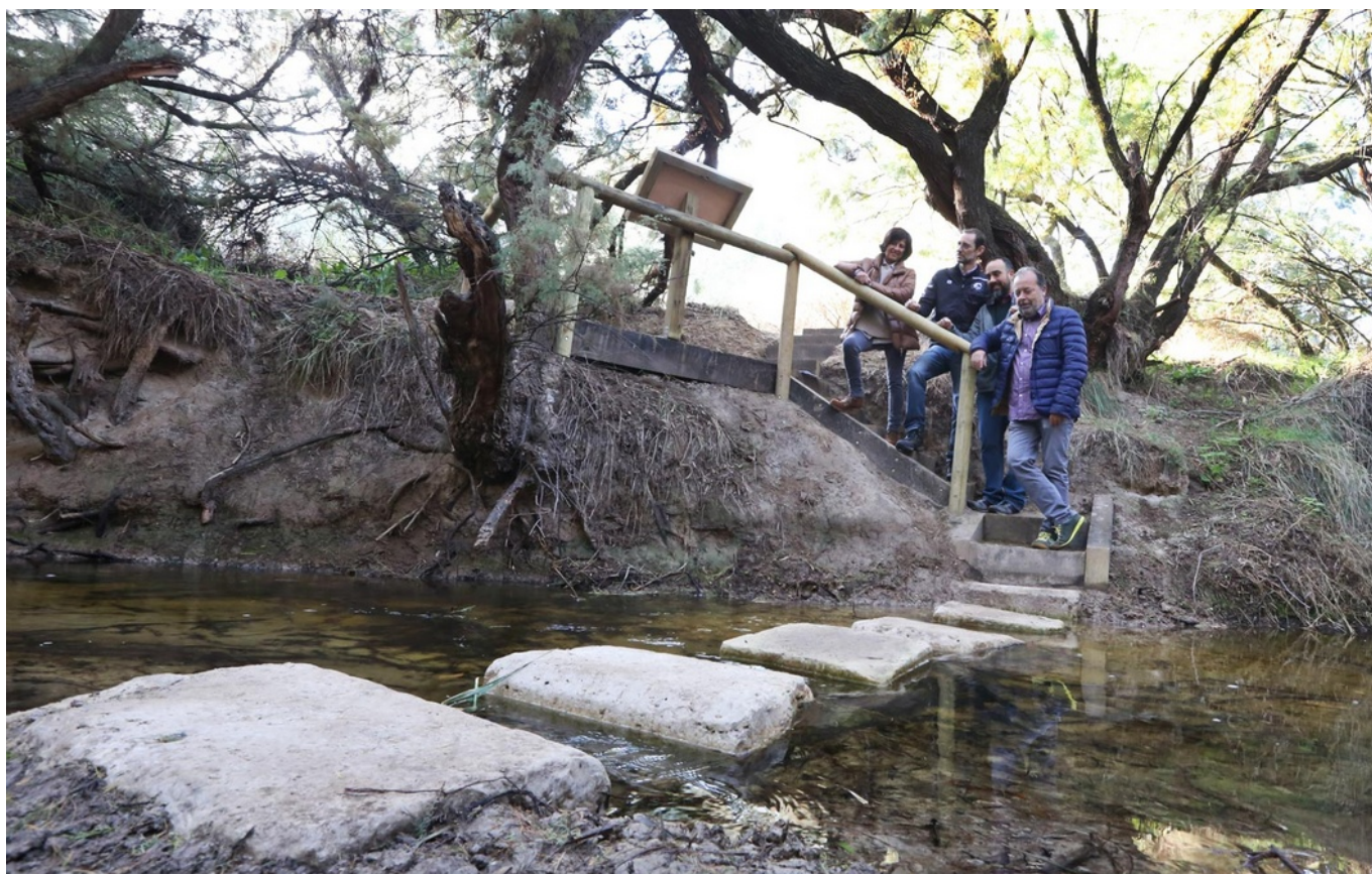
La actuación permitirá que se cruce por el agua con seguridad | Jesús Cruces.
