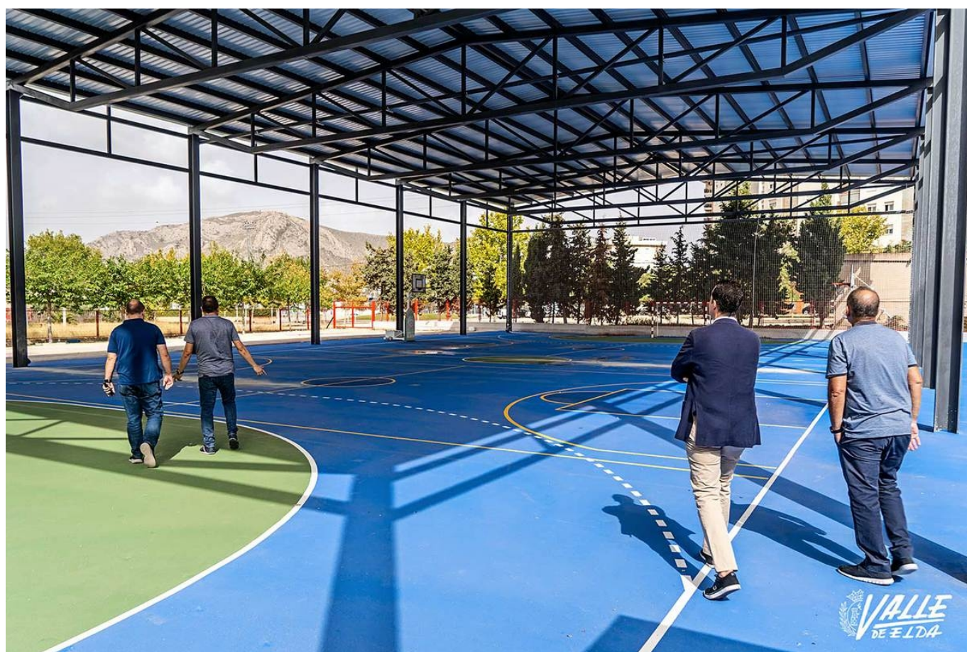
En la obra destaca la nueva cubierta | Nando Verdú.
