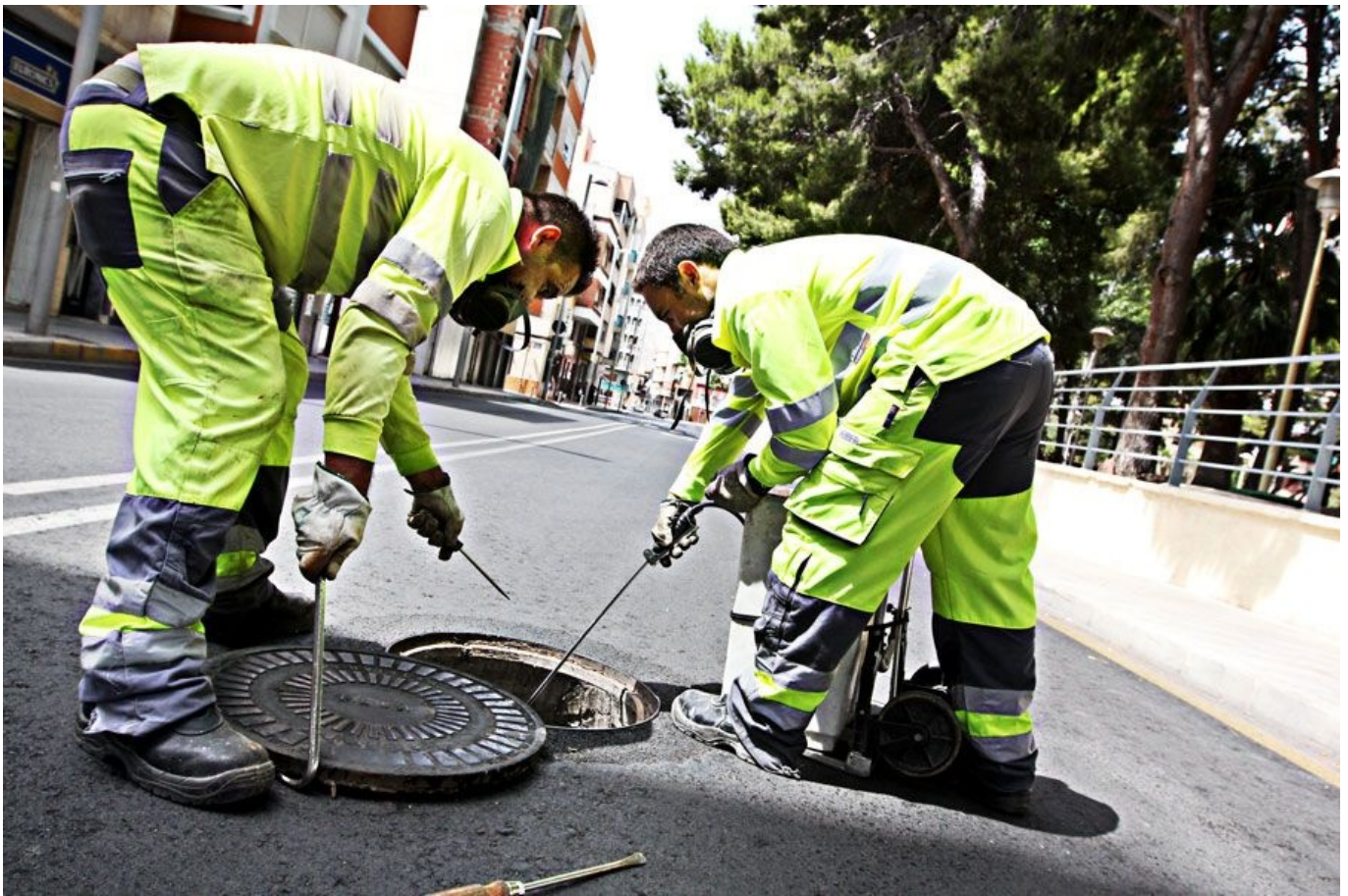
Los trabajadores fumigando el alcantarillado de la ciudad | Jesús Cruces
