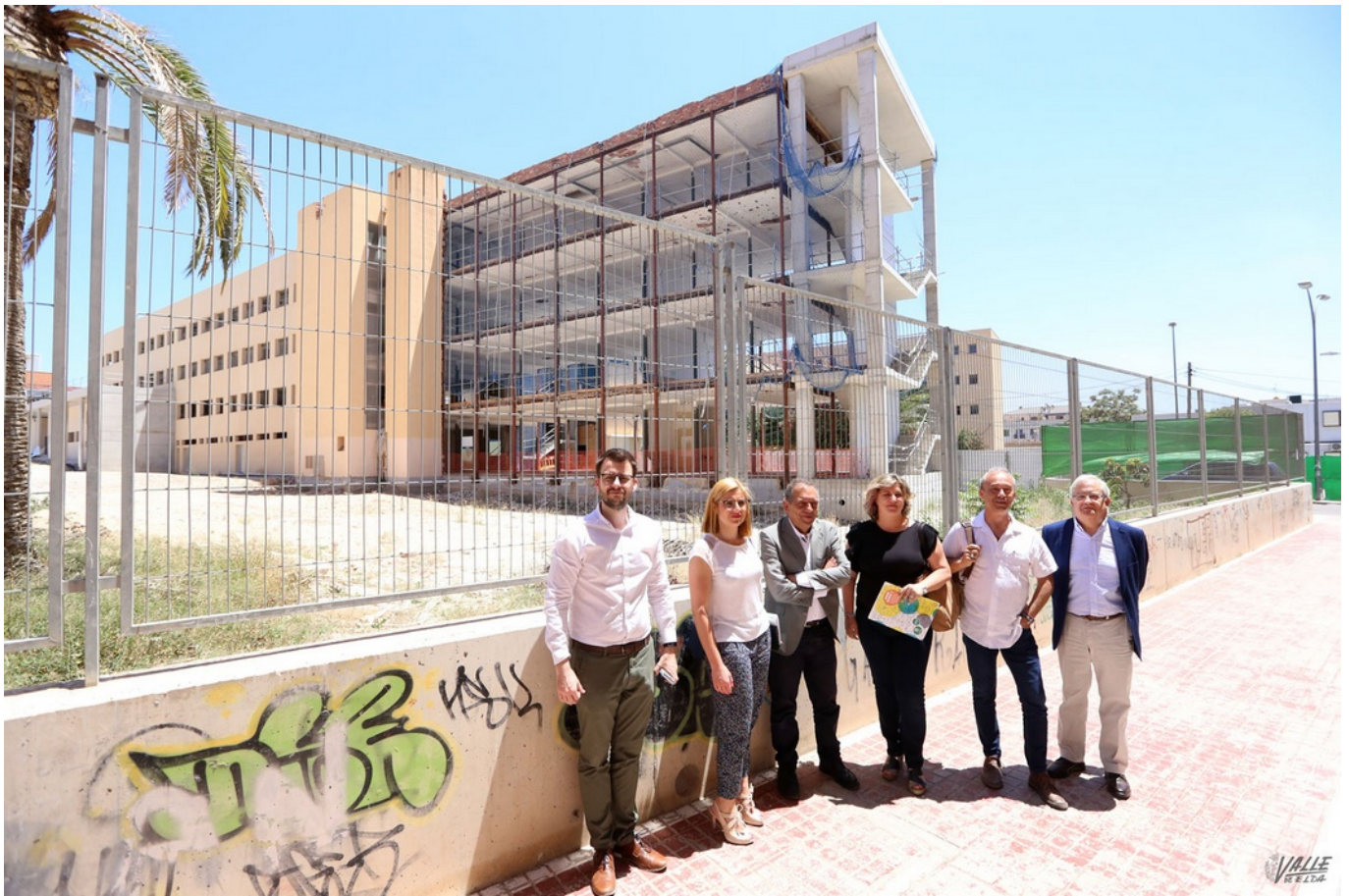
Parte del instituto, en primer término, tendrá que ser derribado por las deficiencias | Jesús Cruces.
