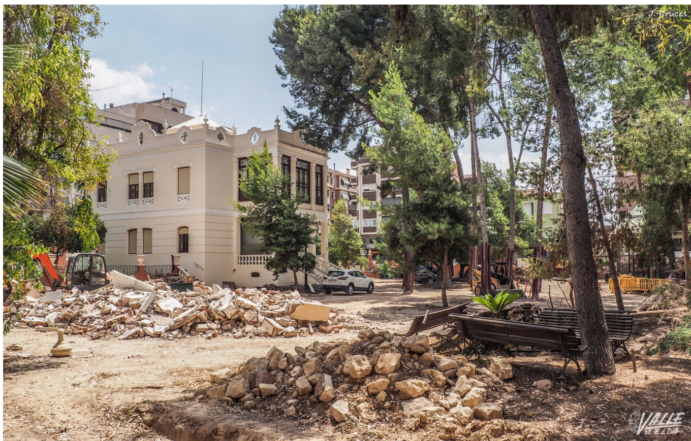
Por el momento se ha demolido la antigua cafetería | J.C.
