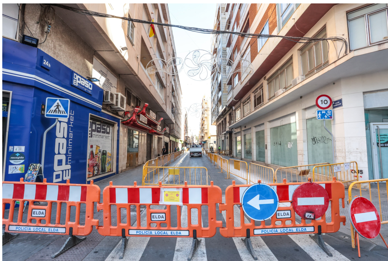
La calle ya se ha cortado al tráfico
