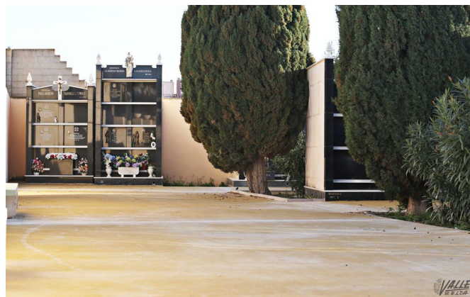
Una de las calles ya asfaltadas, lo que dota de más seguridad al cementerio | Jesús Cruces.
