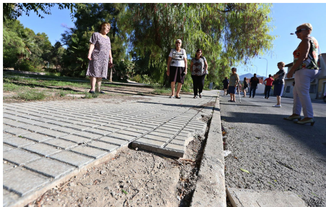
Parte de la acera del paseo de las Arenas está levantada | Jesús Cruces.
