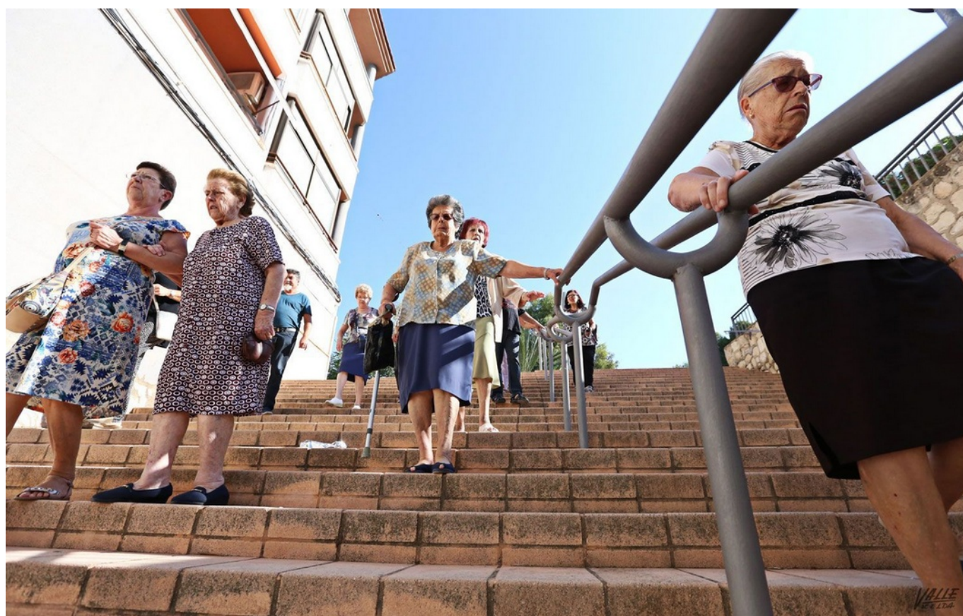
Los vecinos piden una rampa pues la escalera de acceso es problemática | Jesús Cruces.
