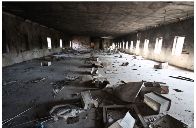
El Ayuntamiento ha intervenido de manera subsidiaria para poder derribar el edificio | Jesús Cruces.
