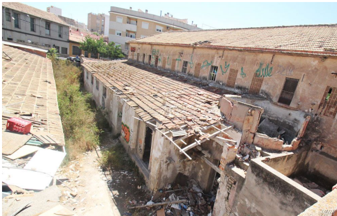
La demolición finalizará en dos meses | Jesús Cruces.
