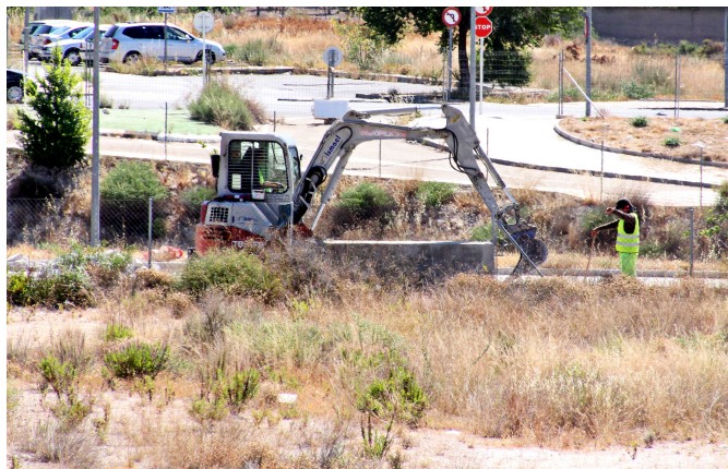
Los trabajadores ya están instalando la red eléctrica | Jesús Cruces
