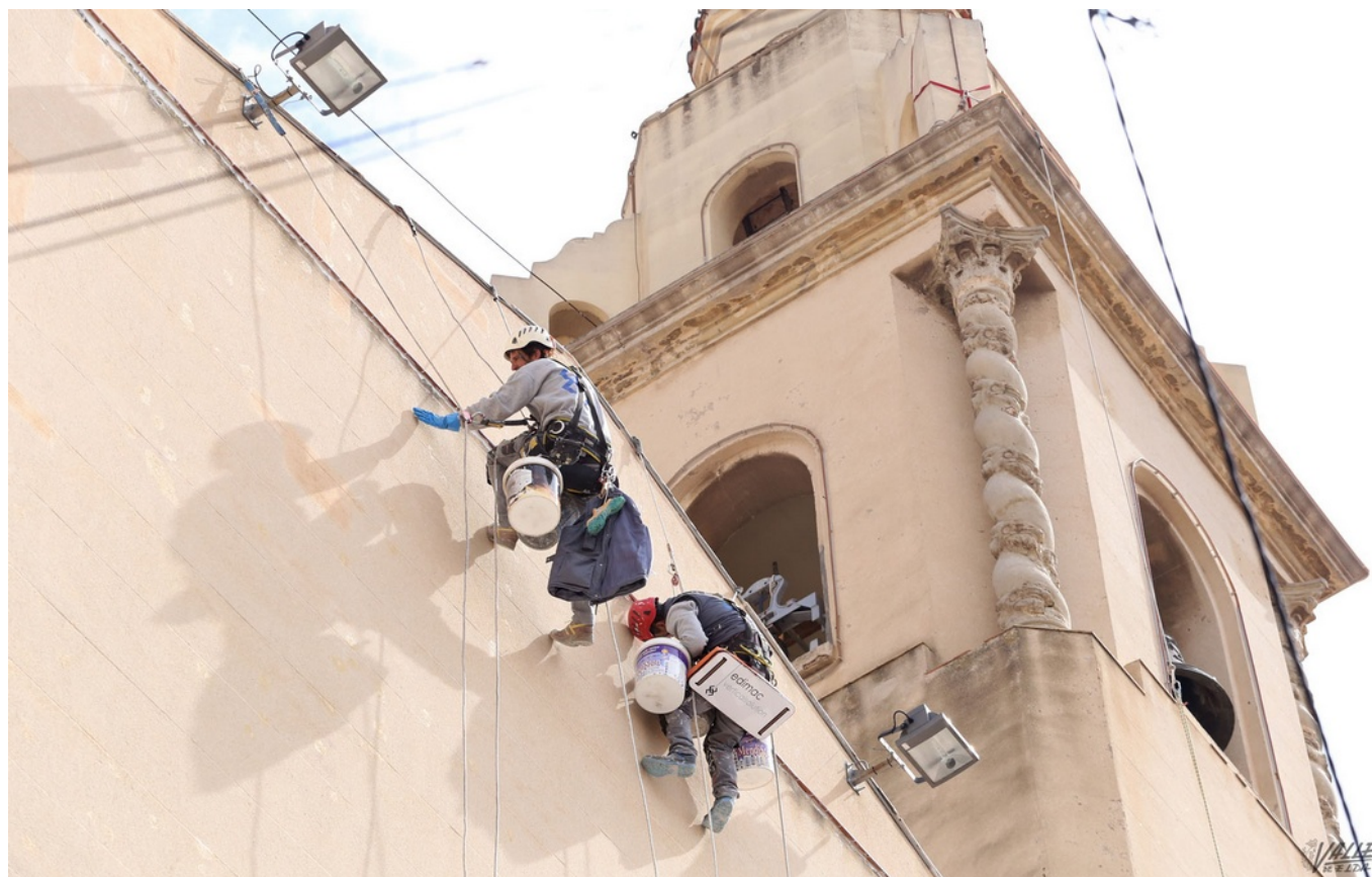
Los trabajadores realizan la obra descolgados en todo momento | Jesús Cruces.
