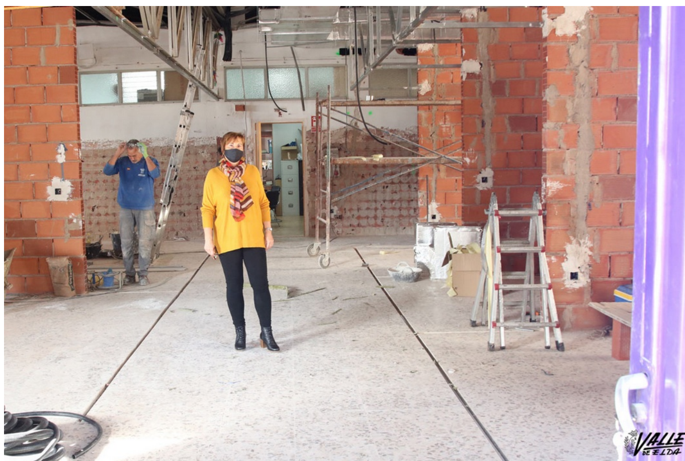
Loli Berenguer muestra las obras.
