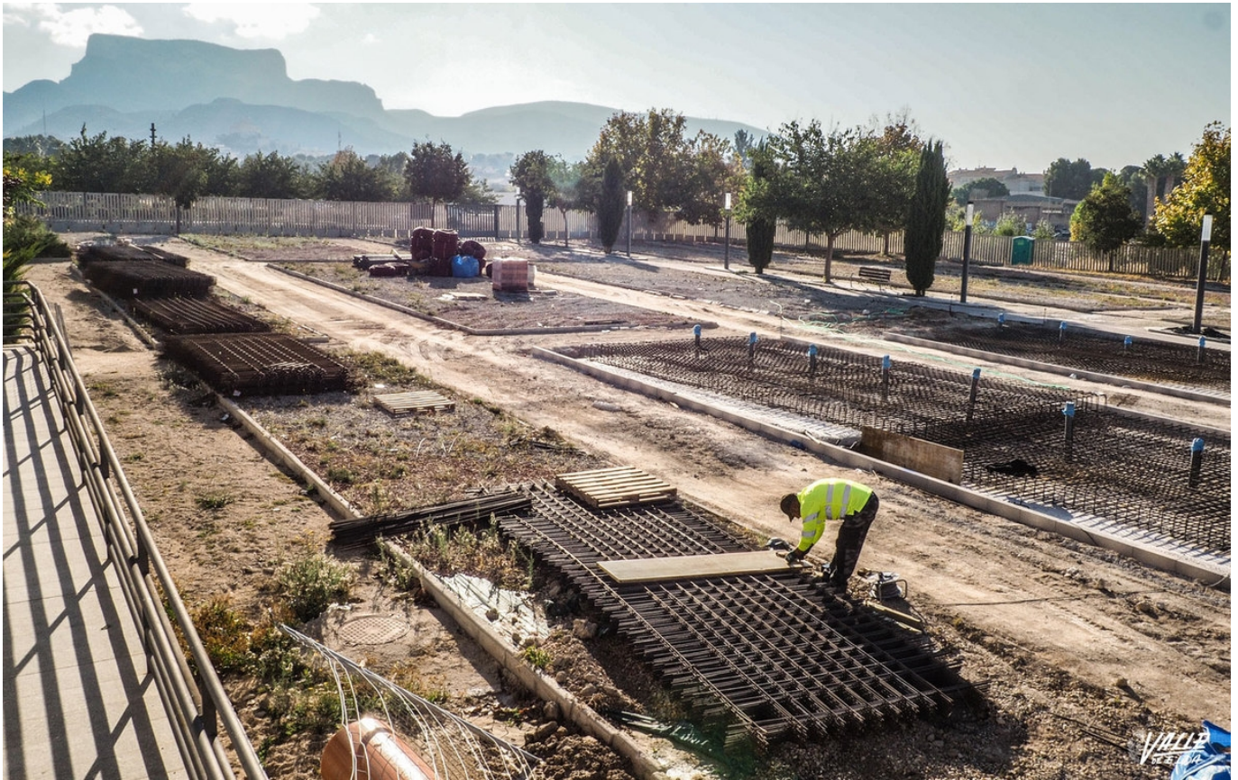
Los trabajos de construcción de los nichos ya han comenzado | J.C.
