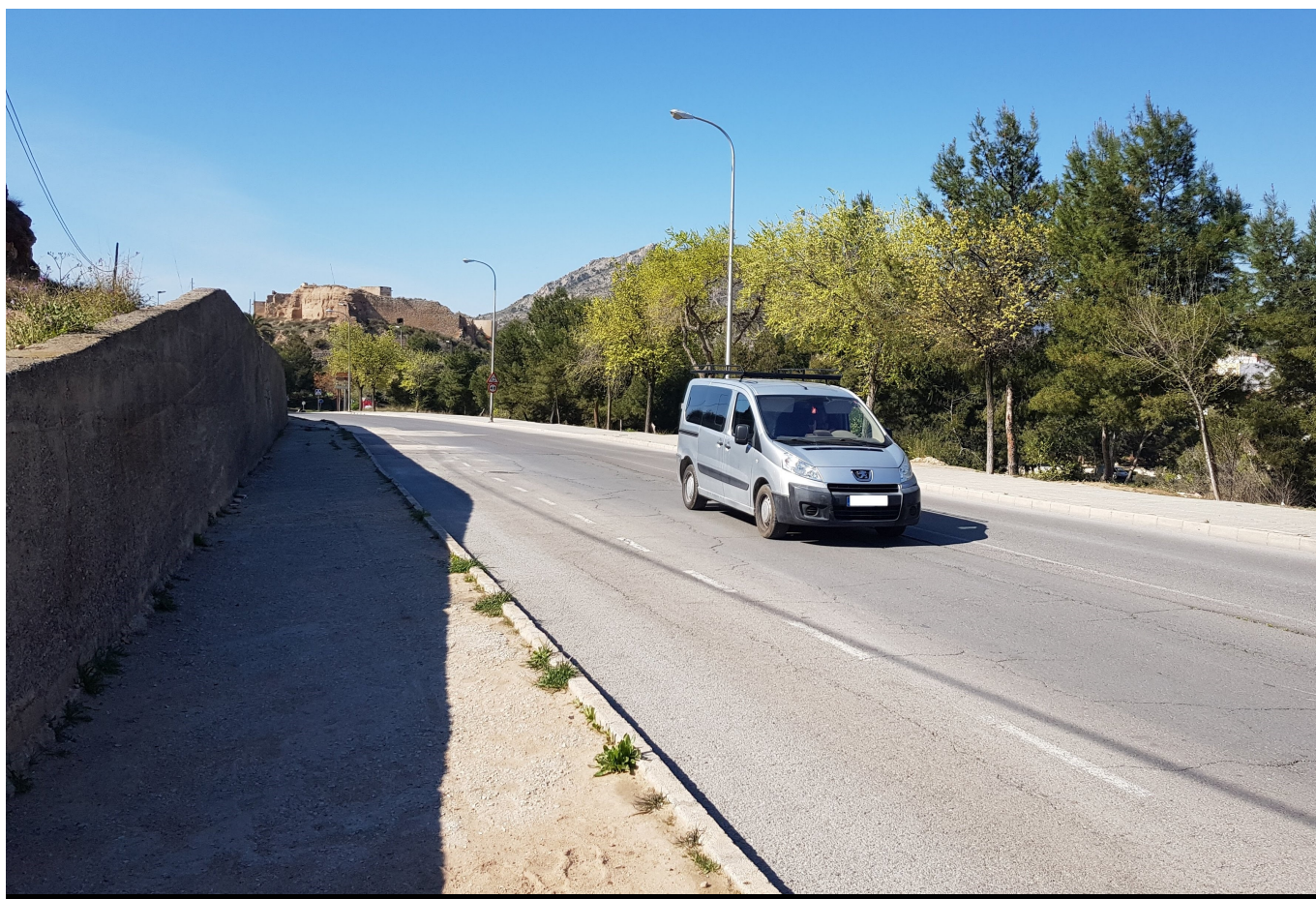
Una escalera unirá la calle Los Leones y la calle Alonso de Coloma.
