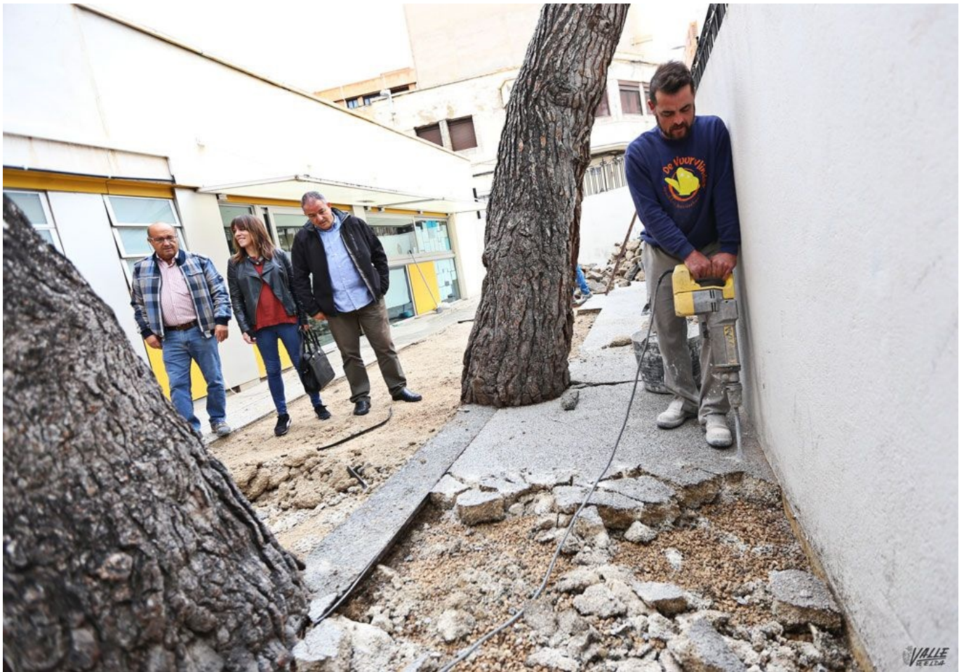
Una brigada municipal está reparando las zonas afectadas en Padre Manjón | Jesús Cruces.
