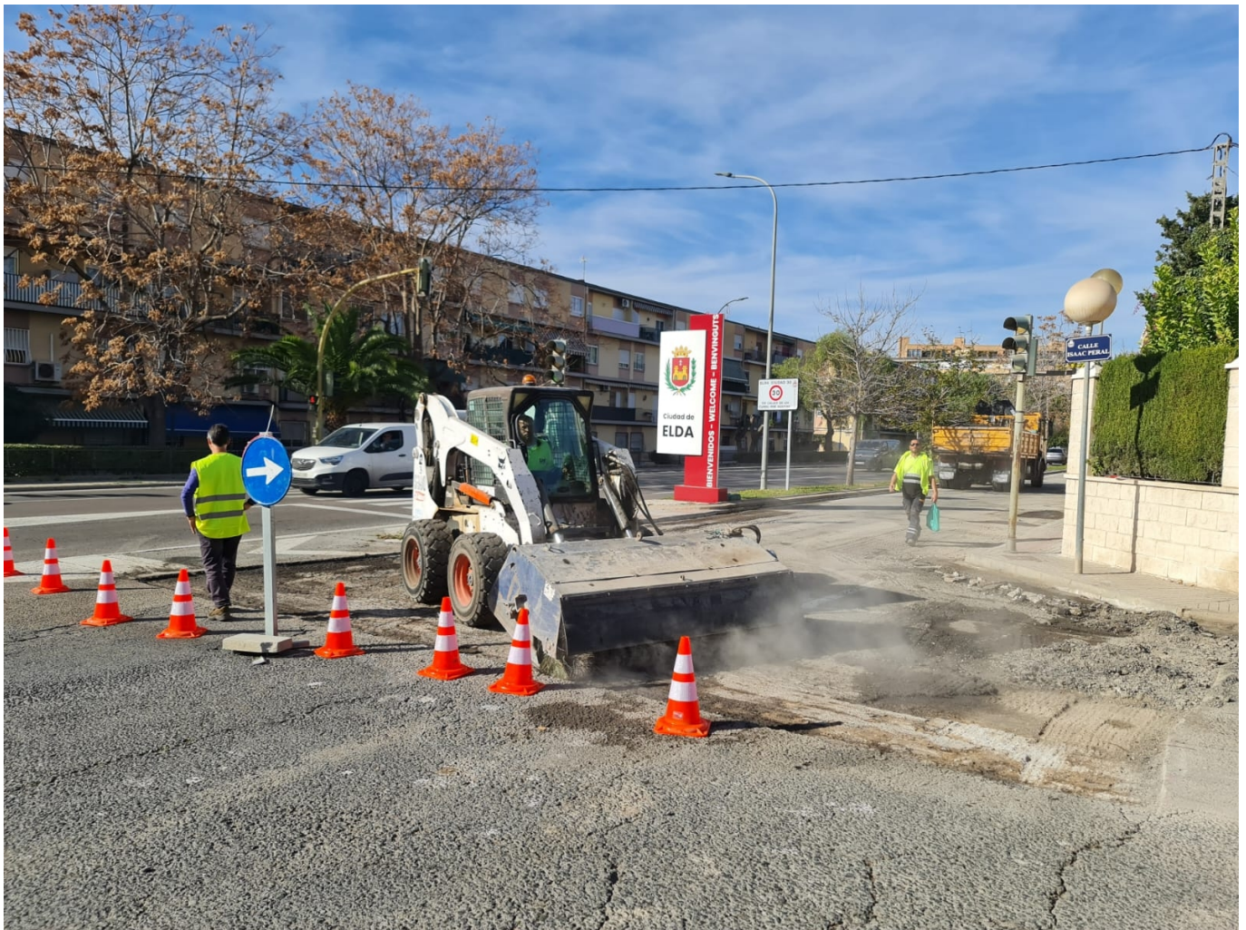
Los trabajos en la avenida de los Eucaliptus ya han finalizado.
