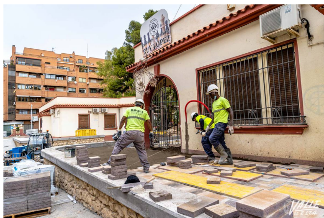
Está prevista la renovación de la iluminación LED de todo el jardín | Nando Verdú.
