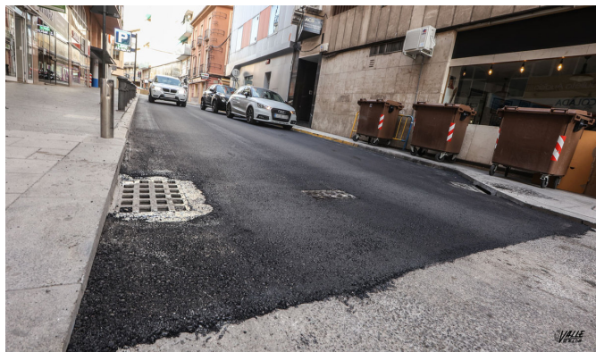
La calle Jardines ha sido reasfaltada en parte.
