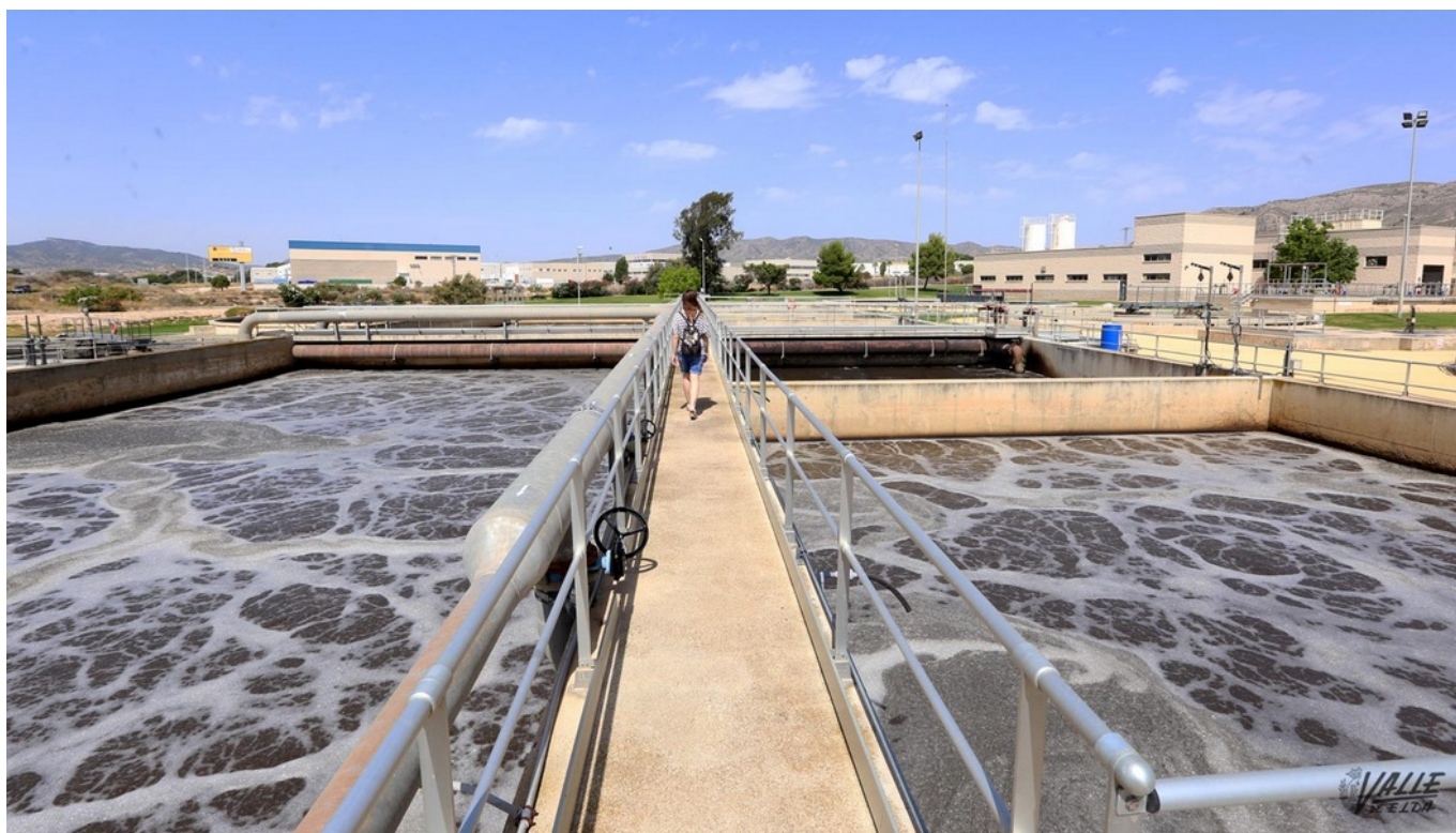
Imagen de la depuradora de Elda.
