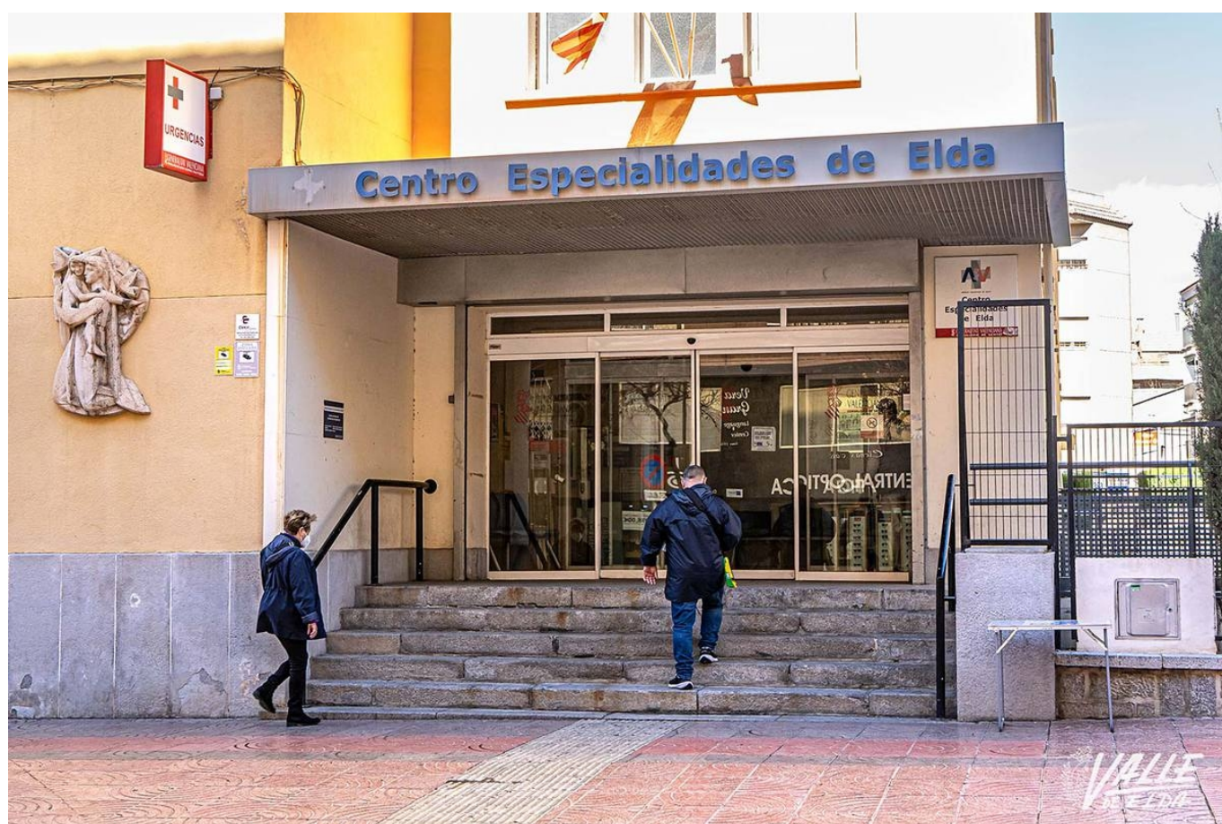
El edificio de especialidades y Urgencias se va a remodelar | Nando Verdú.
