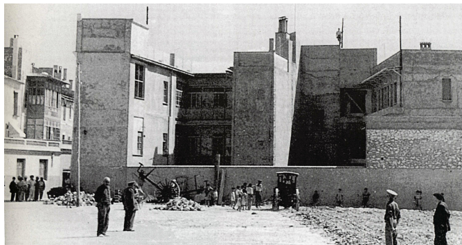
Solar donde hoy se encuentra el edificio de la Caja. José Beneit Andreu, Pepe el de la Ilum, sobre el tejado, instalando la electricidad. Año 1956.
