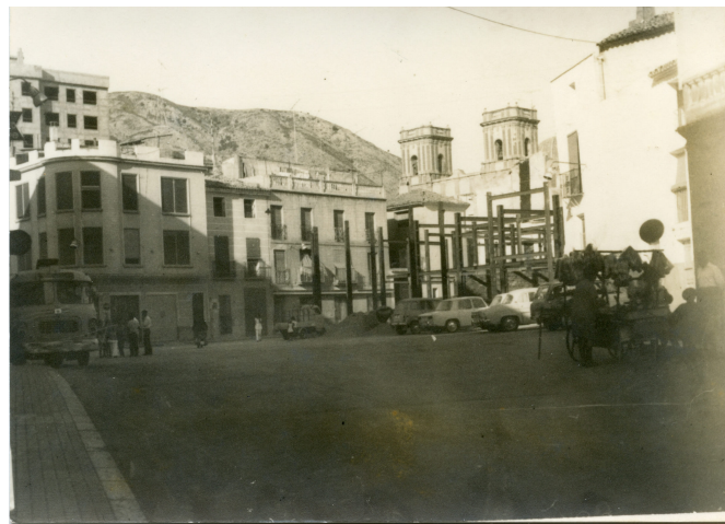
El edificio Maracaibo en su fase inicial de construcción | José Esteve.
