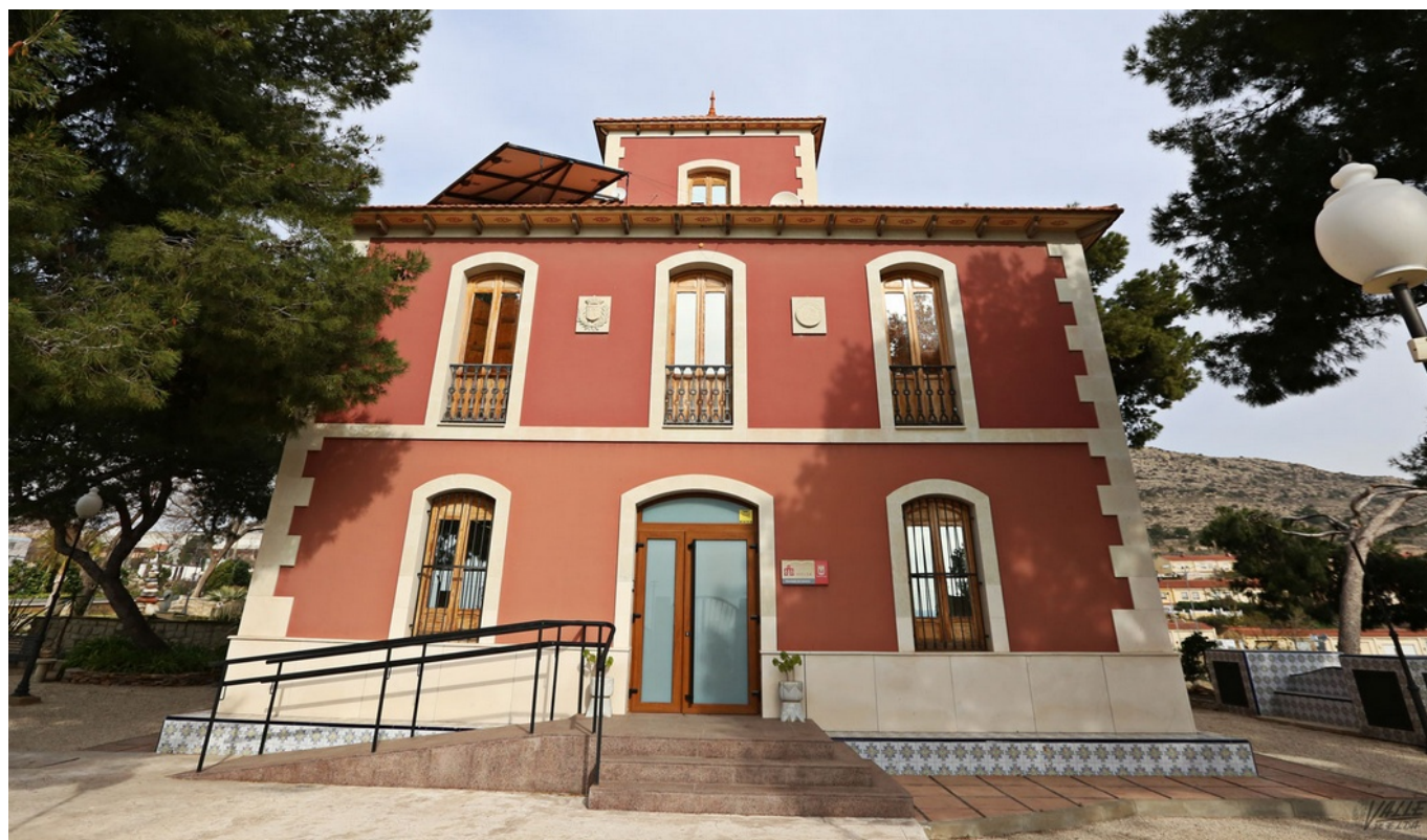
La Casa Colorá podrá ser el centro de interpretación del patrimonio local | Jesús Cruces.
