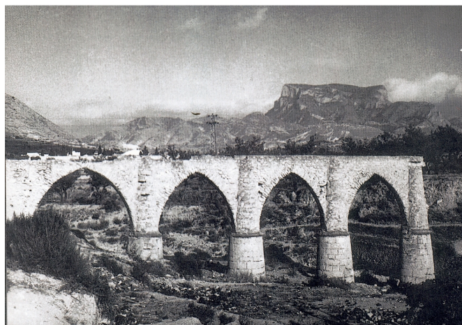
Acueducto de la rambla de Puça (s. XVII), construido por la vila de Elda para el abastecimiento de las fuentes públicas
