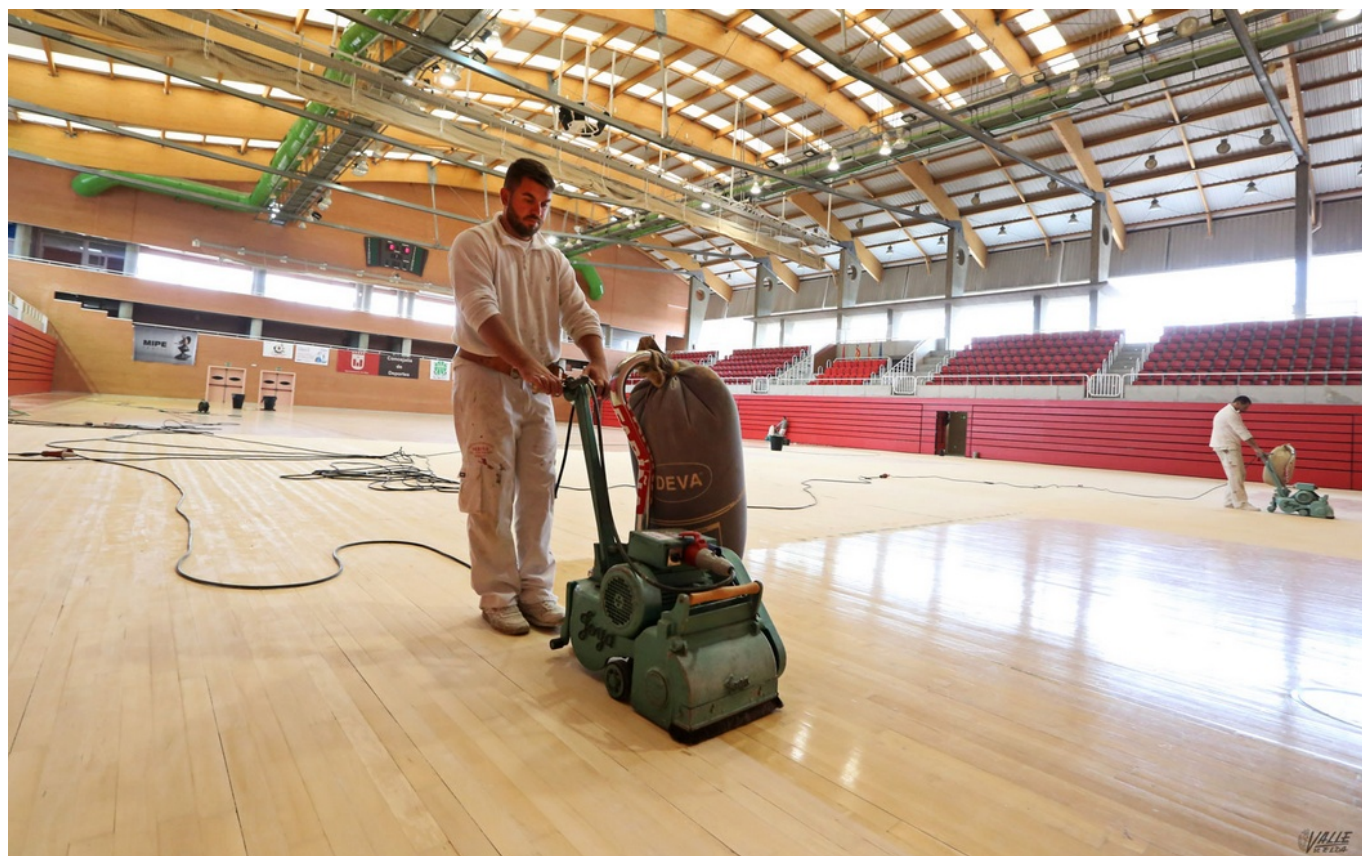
Actualmente se está lijando el parqué del Ciudad de Elda | Jesús Cruces.
