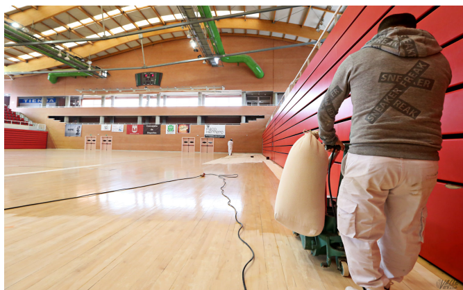
Imagen actual del pabellón en obras | Jesús Cruces.
