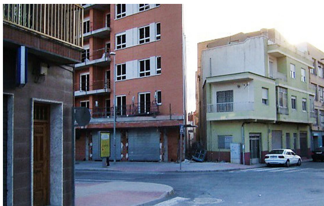
Vista del callejón del Campico que comunica la Avenida de Madrid (Petrer) con la calle Santo Domingo de Guzmán (Elda) y que constituye parte del trazado de la antigua Acequia de Arriba. El edificio alto es término municipal de Petrer y la edificación de la esquina, en la que nace la calle Murillo, es término municipal de Elda.
