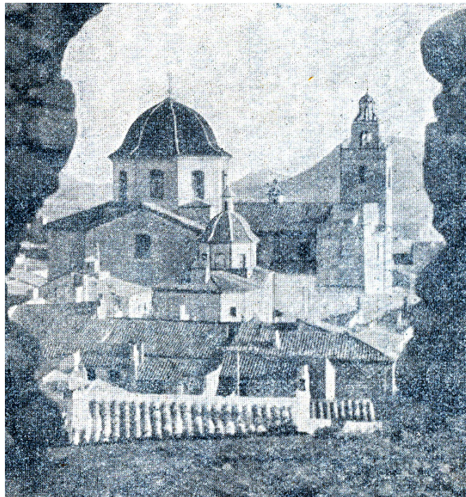
Vista de la antigua iglesia de Santa Ana, de Elda, desde el castillo. Se observa el volumen exterior de la capilla de la Virgen de la Salud y la pequeña cúpula sobre tambor, con linterna superior, que coronaba la capilla
