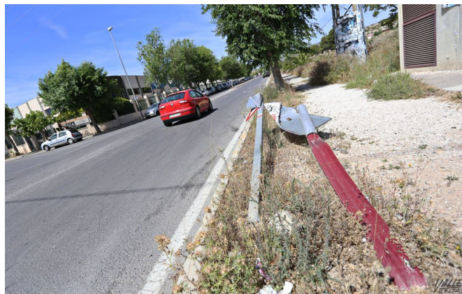
Algunas señales de tráfico permanecen caídas | Jesús Cruces.
