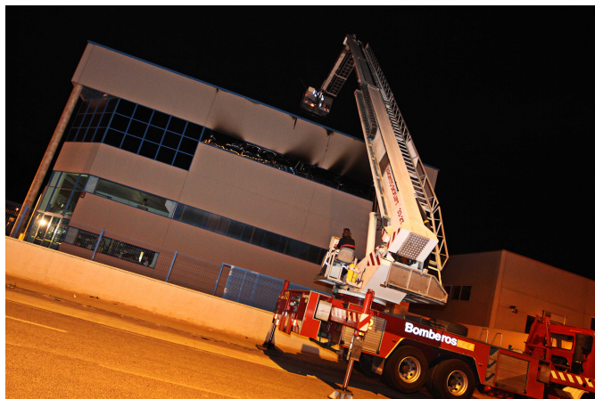
Los daños provocados por las llamas eran visible en la parte superior del edificio | Jesús Cruces
