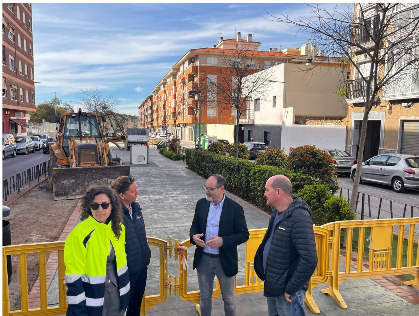
El edil ha acudido a las obras en la avenida Felipe V.
