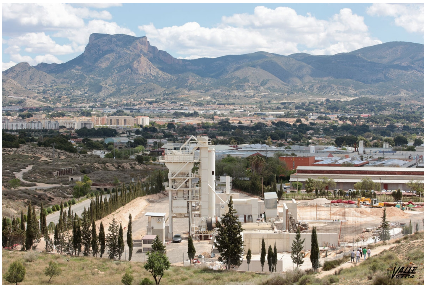
Imagen de la planta asfáltadora.
