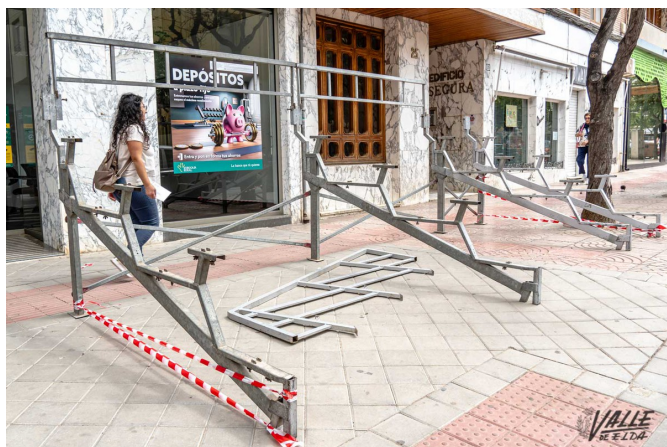
Las tribunas ya se están instalando | Nando Verdú.
