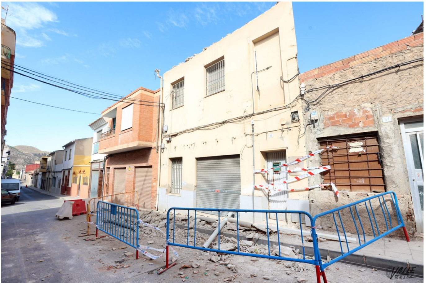
Imagen de la vivienda.
