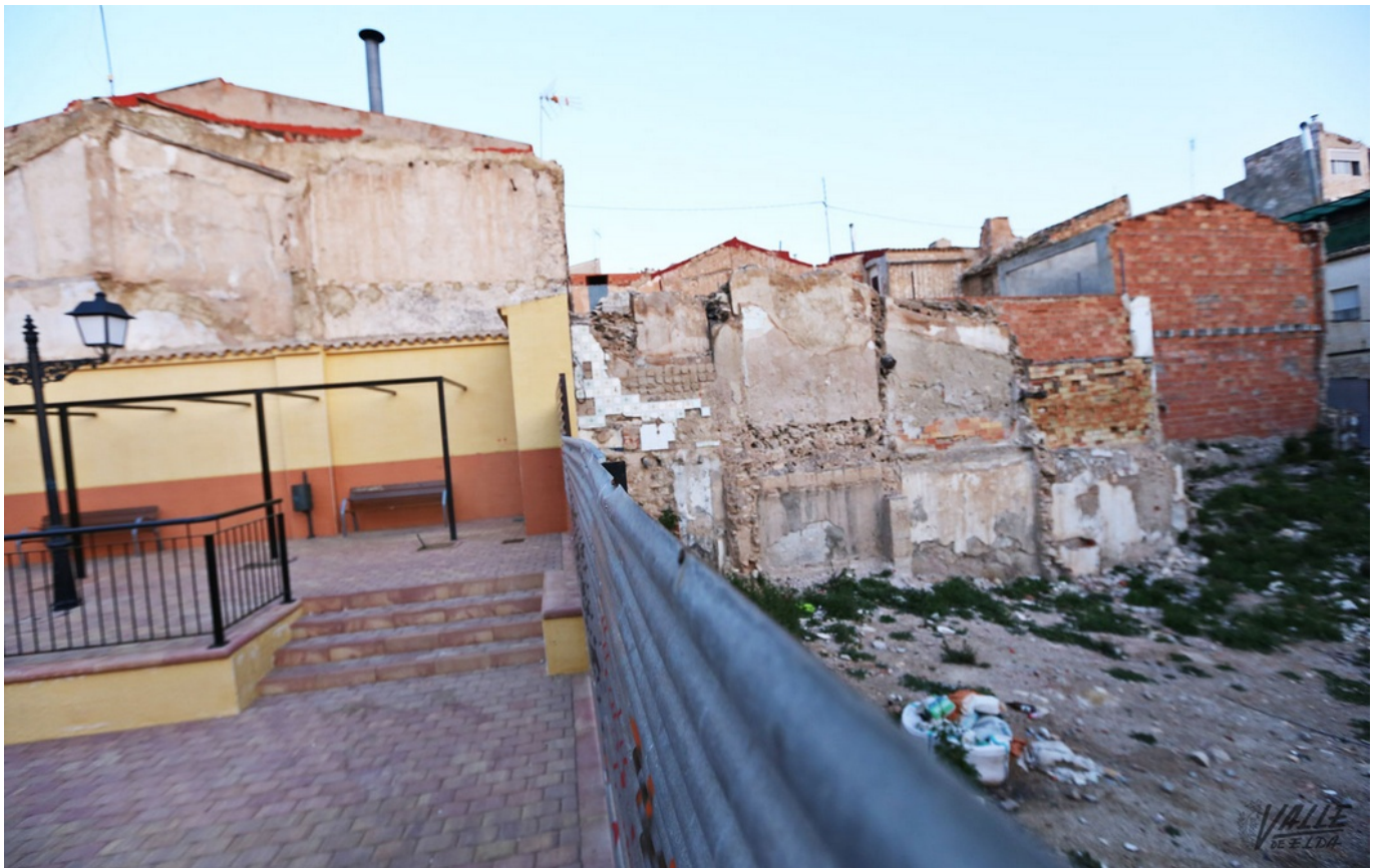
Imagen de la actual plazoleta y la zona en la que se crearán los aparcamientos | Jesús Cruces.
