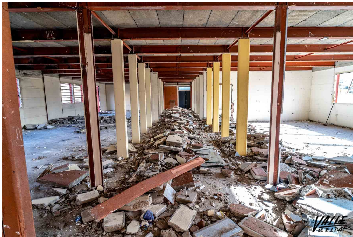
El edificio ya está siendo derribado | Nando Verdú.
