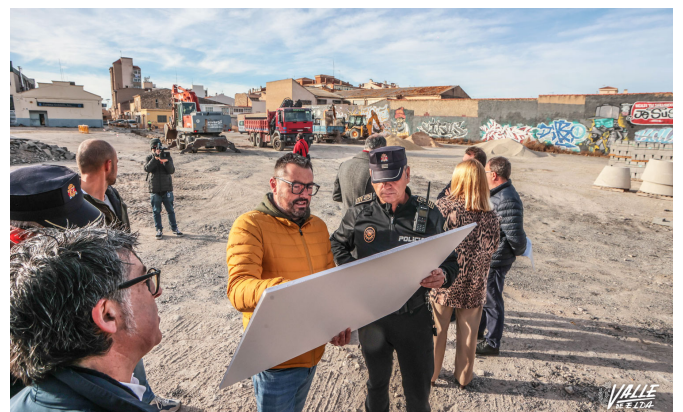
Estas obras tienen un presupuesto de 1,3 millones de euros
