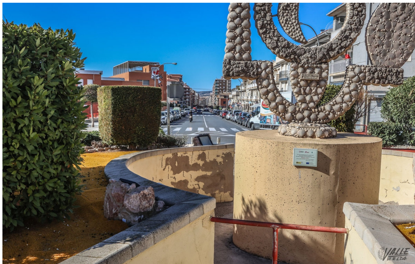
Izquierda Unida de Petrer propone la remodelación de la rotonda para evitar inundaciones durante las lluvias torrenciales | J.C.
