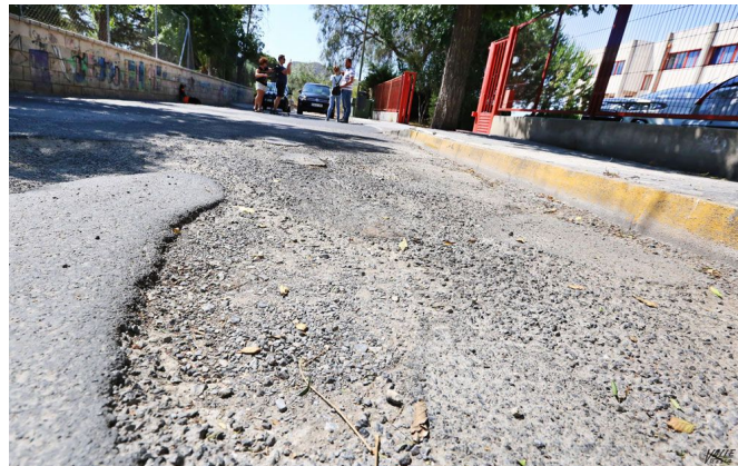
El acceso a este edificio tiene numerosas deficiencias | Jesús Cruces.
