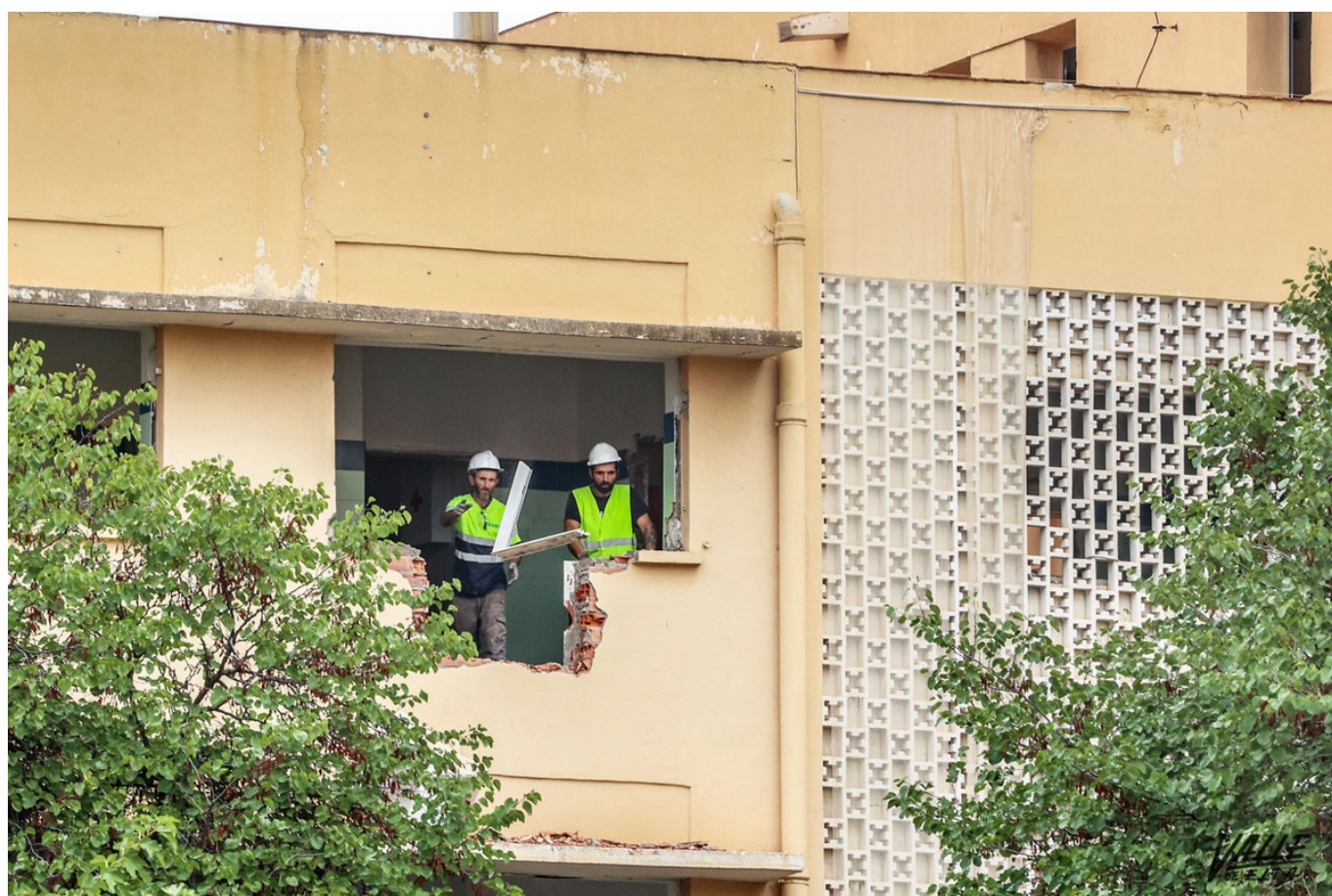
Los trabajadores ya están preparando el edificio para su demolición.
