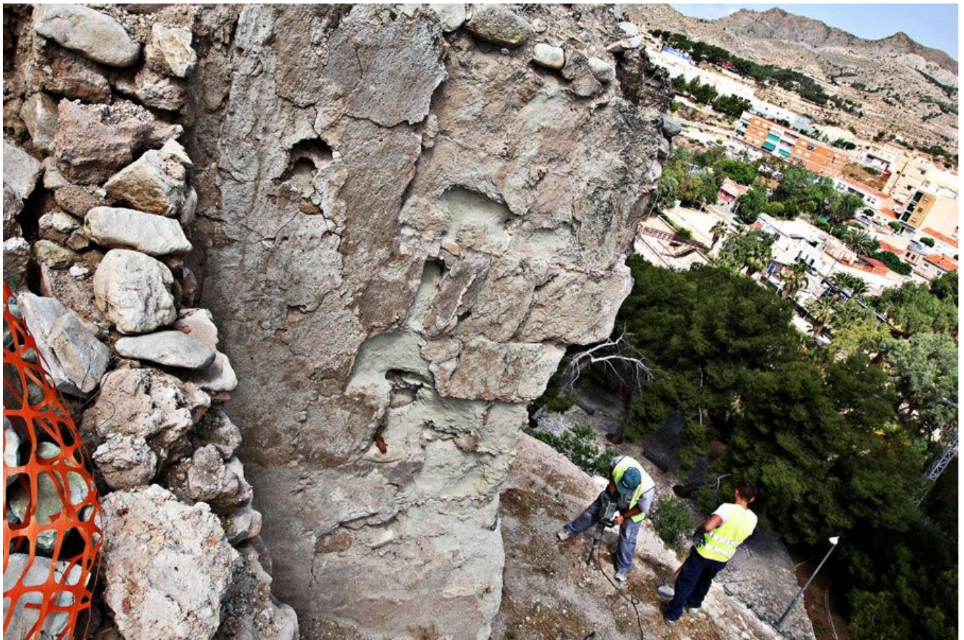
Las obras tienen un plazo de siete meses | Jesús Cruces
