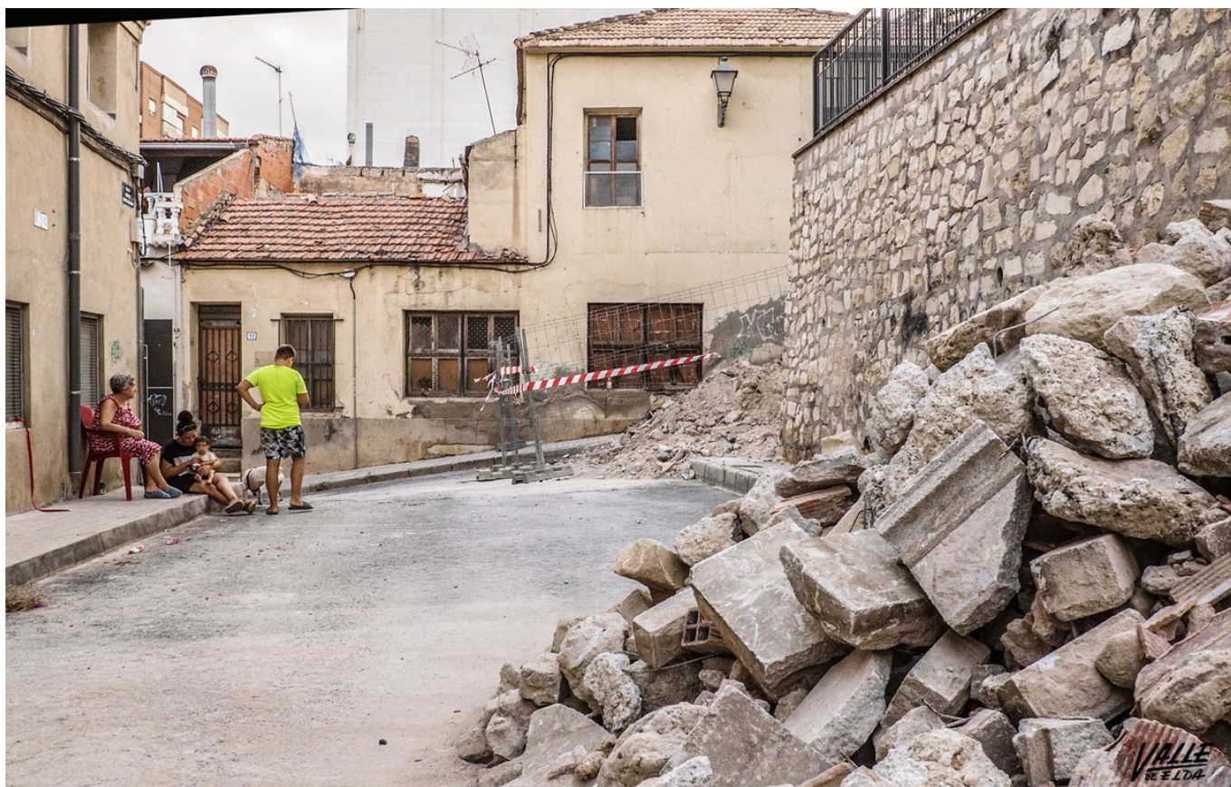
Las obras de las plazas Matadero y Santiago ya han arrancado | J.C.
