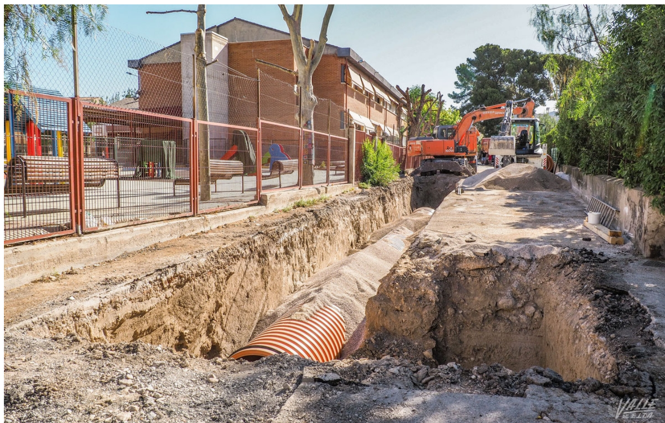
La primera fase de las obras durarán un mes.
