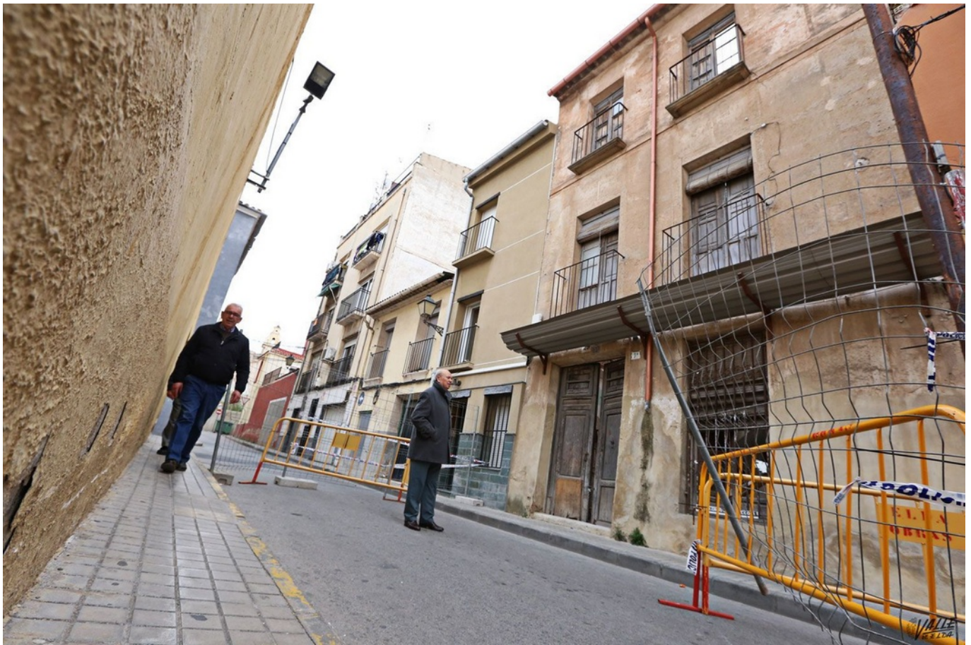
José Miguel Tornero, lamenta que la calle permanezca cortada y suponga un peligro para los vecinos | Jesús Cruces.
