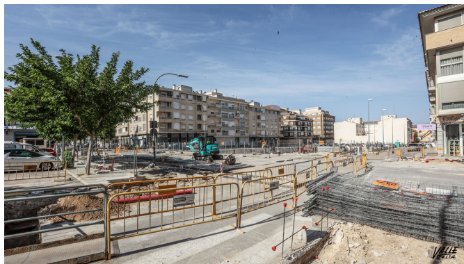
Actualmente se está realizando el bulevar en la zona del centro de salud.
