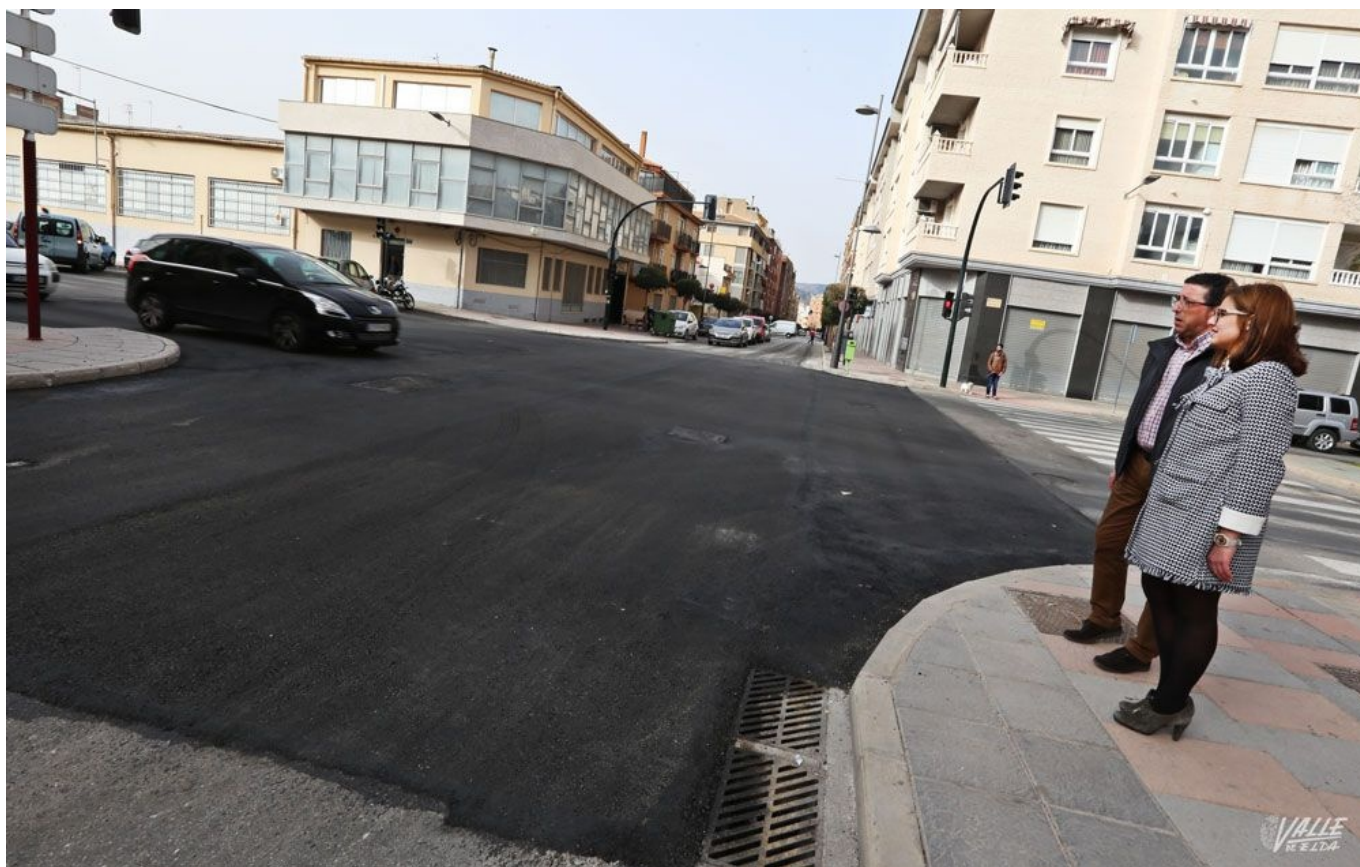
El cruce entre las avenidas de Elda y Felipe V ha sido repavimentado | Jesús Cruces.
