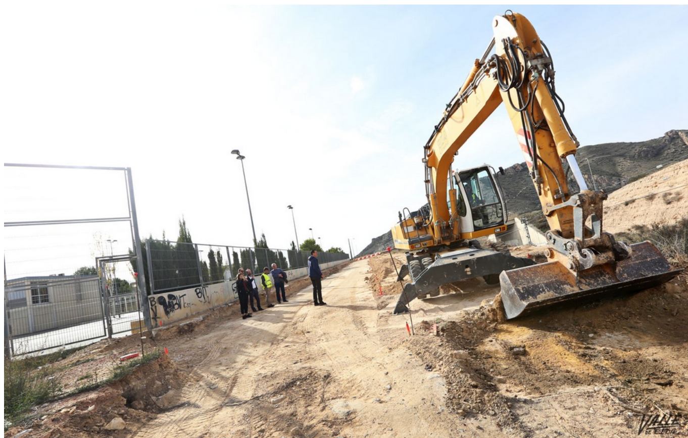
Las obras han comenzado esta semana | Jesús Cruces.
