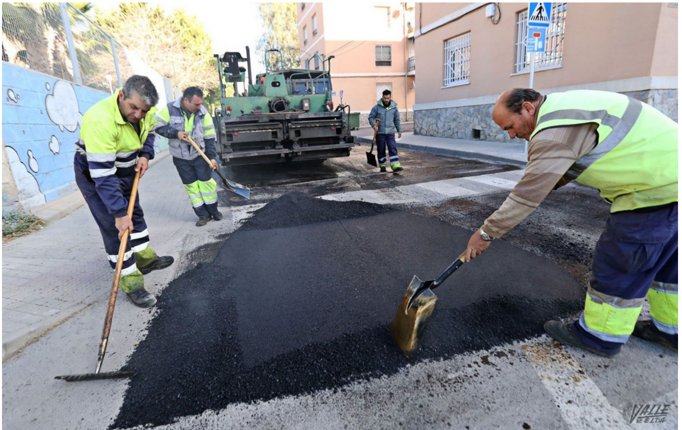
Imagen de archivo del asfaltado de una calle de la ciudad | Jesús Cruces.
