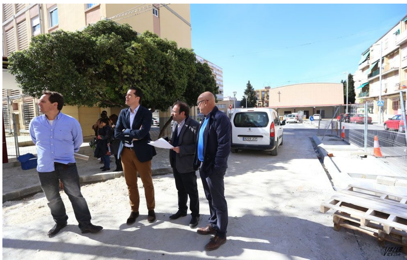
Alfaro ha visitado las obras de San Francisco de Sales | Jesús Cruces.
