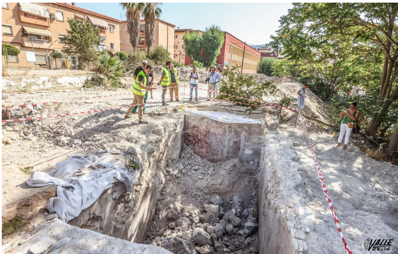
Los muros de un aljibe se han hallado en las catas de la zona que será la escuela infantil Santa Infancia | J.C.
