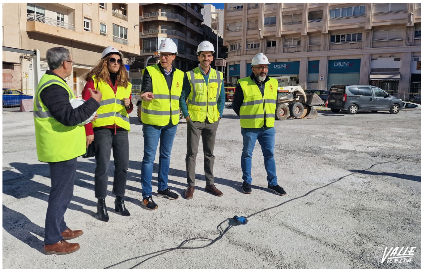
Alfaro, Amat y los técnicos han visitado esta mañana las obras.
