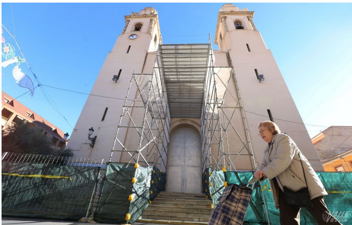
El espacio se ha acotado y se ha instalado un gran andamio | Jesús Cruces.
